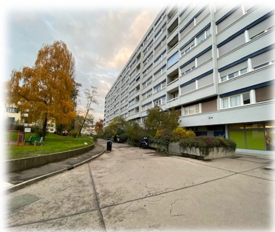
Bacs végétalisés actuels Vieusseux 1 à 7
